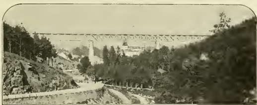
Abb. 161. Viaduct über das Startscherthal. [Segen-Gottes-Okriško.]
